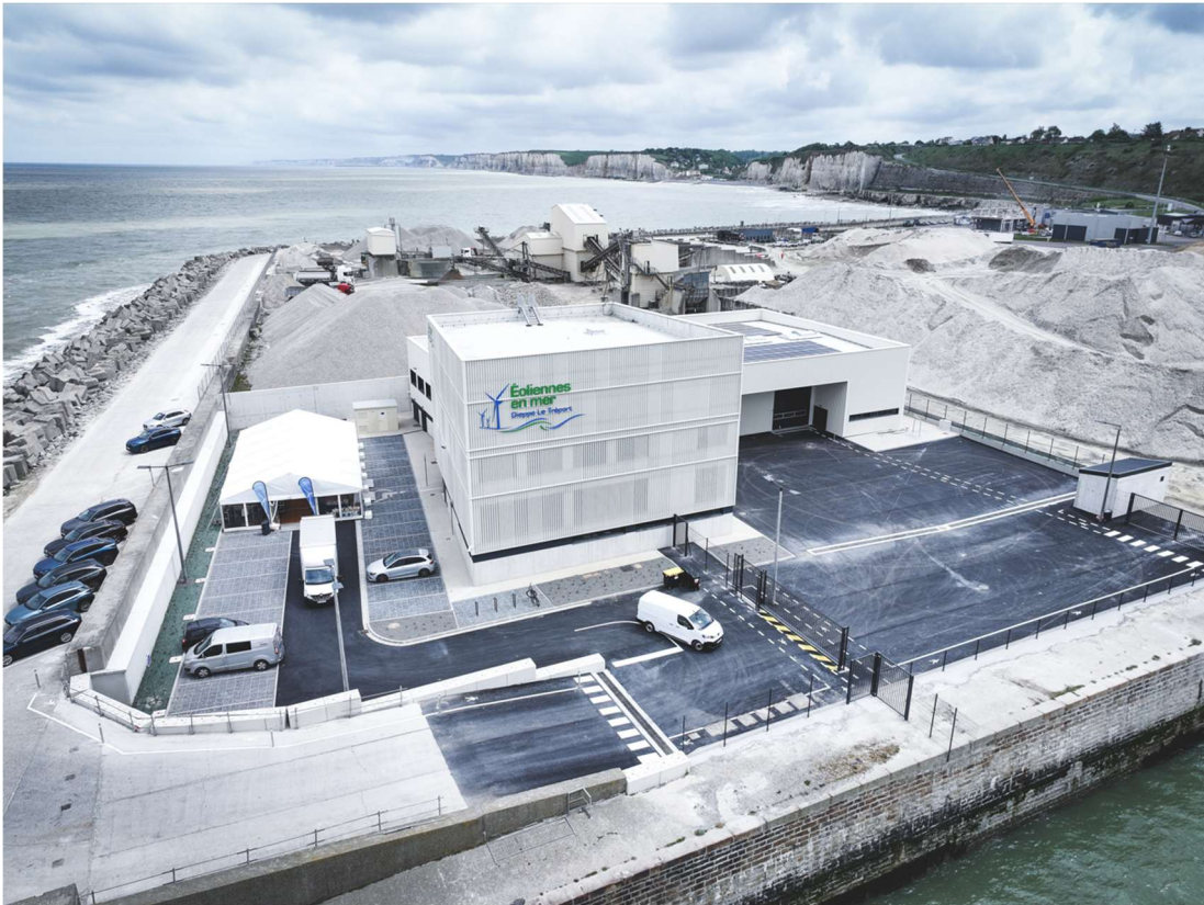
Base de maintenance du parc éolien de Dieppe Le Tréport (EMDT) construite à 100% par des acteurs locaux
