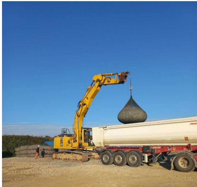
Sacs de granulats pour maintenir les câbles inter-éoliennes fournis par l'acteur local Nexstone et issu d'une carrière vendéenne pour le parc de l'île d'Yeu et de Noirmoutier (EMYN).
