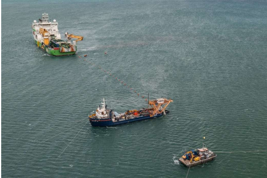
Pose du câble en mer du Projet EFGL (RTE)
