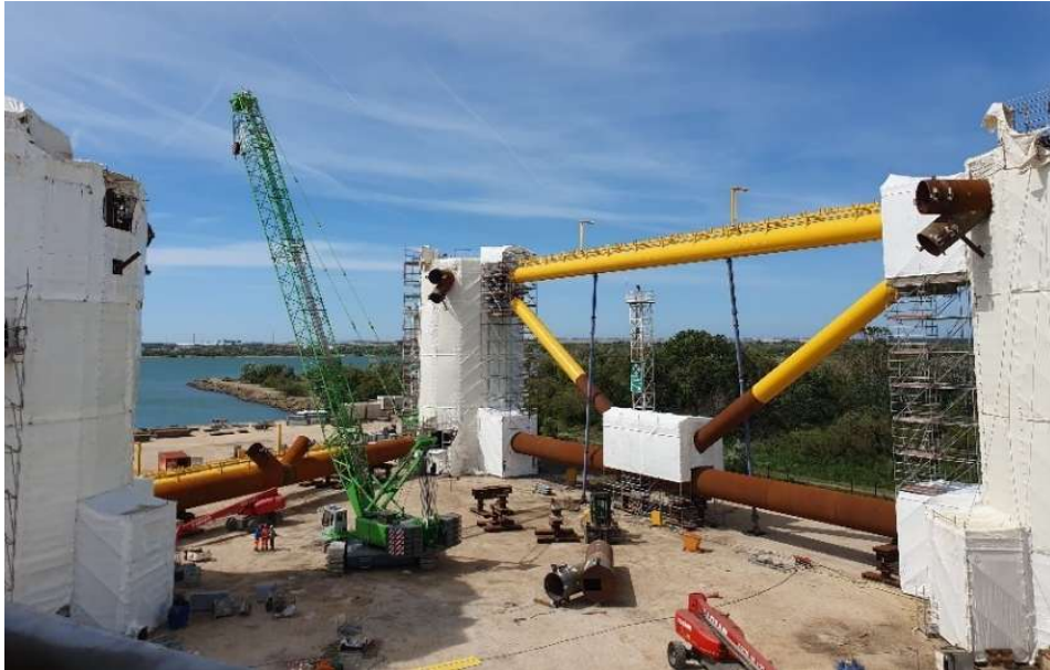
Construction des flotteurs du Projet EFGL à Fos-sur-Mer (OW)
